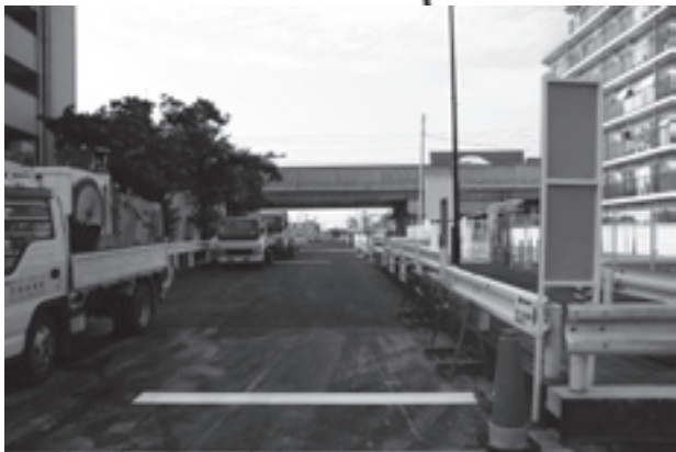
←千川通りから撮影した 工事現場
