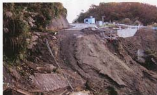
山古志村方面の道路の前壊現場
